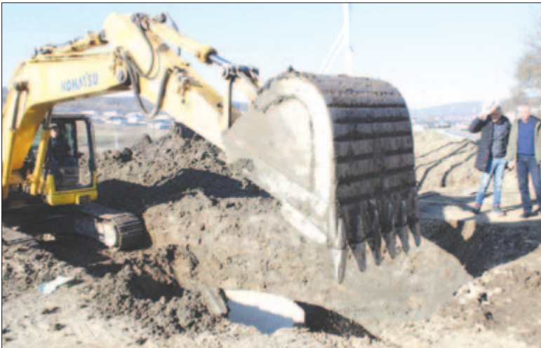
A Kebelét és Kebeleszentiványt kiszolgáló szivattyúállomást építik
