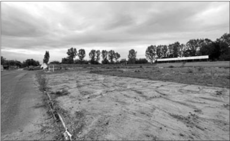
A stadion a felújítás kezdete előtt
