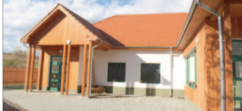
A felújított iskola
