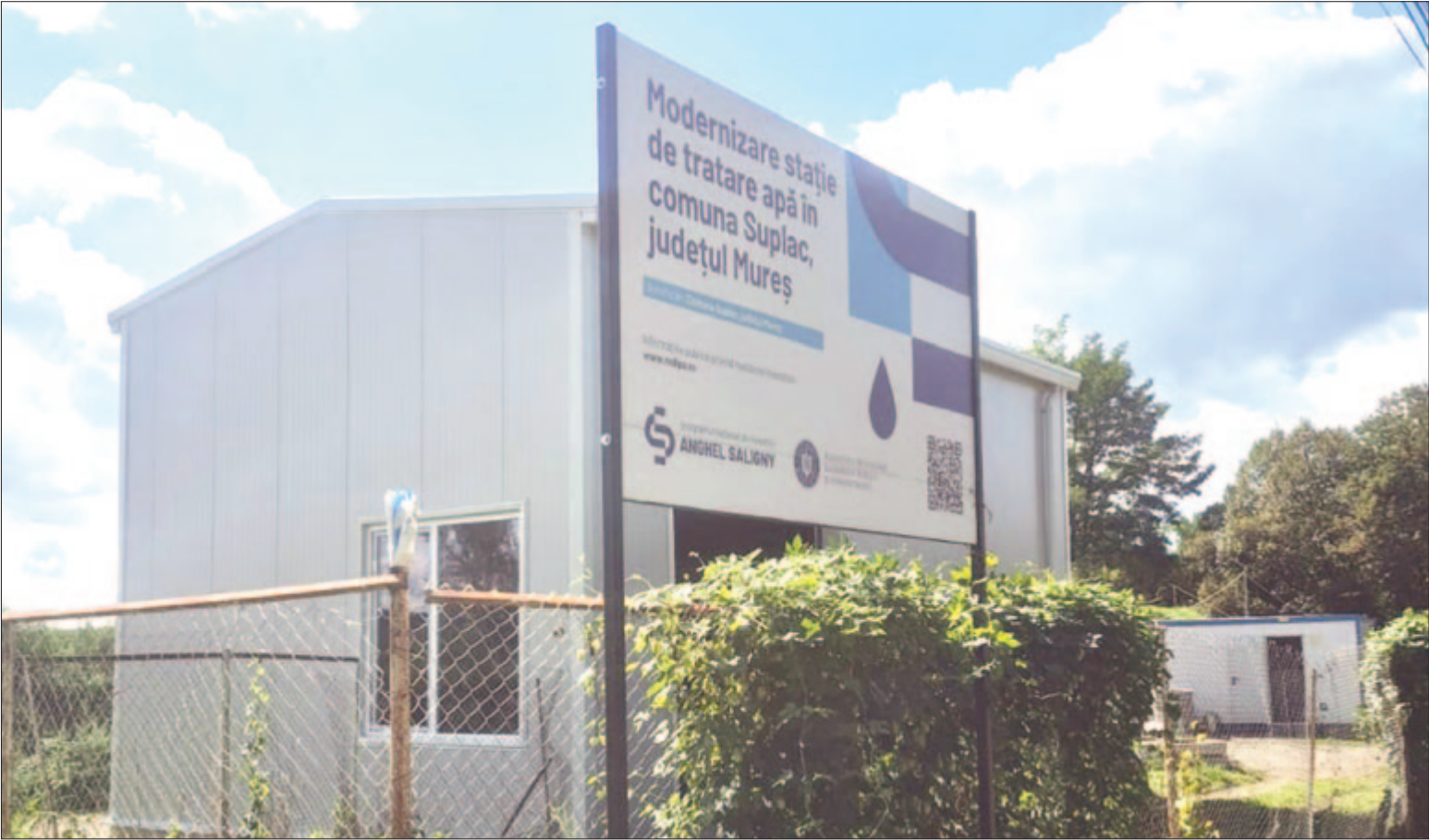
Megépült az új víztisztító, ehhez csatlakoztatják a sótelenítő berendezést
