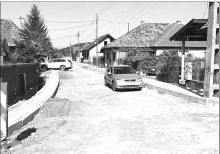
Az aszfaltburkolat mellett sáncok és járdák is épülnek a melléktutkában
