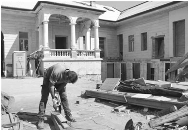
Felújítás alatt volt Klastrom utcai katolikus óvoda
