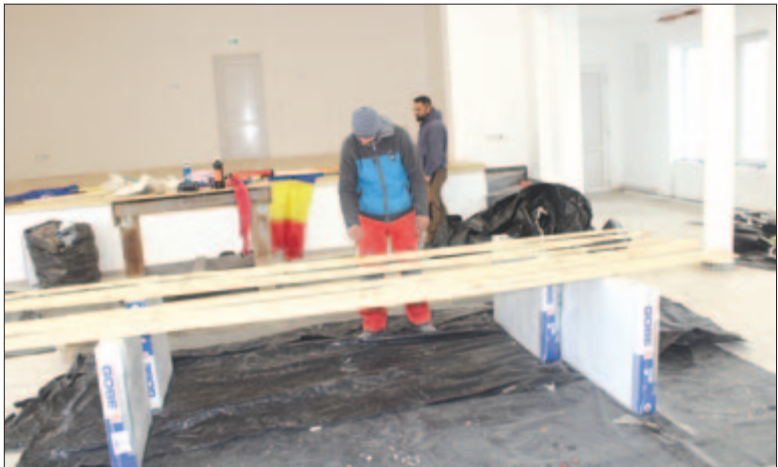
Felújítás alatt a körtvélyfáji kultúrotthon
