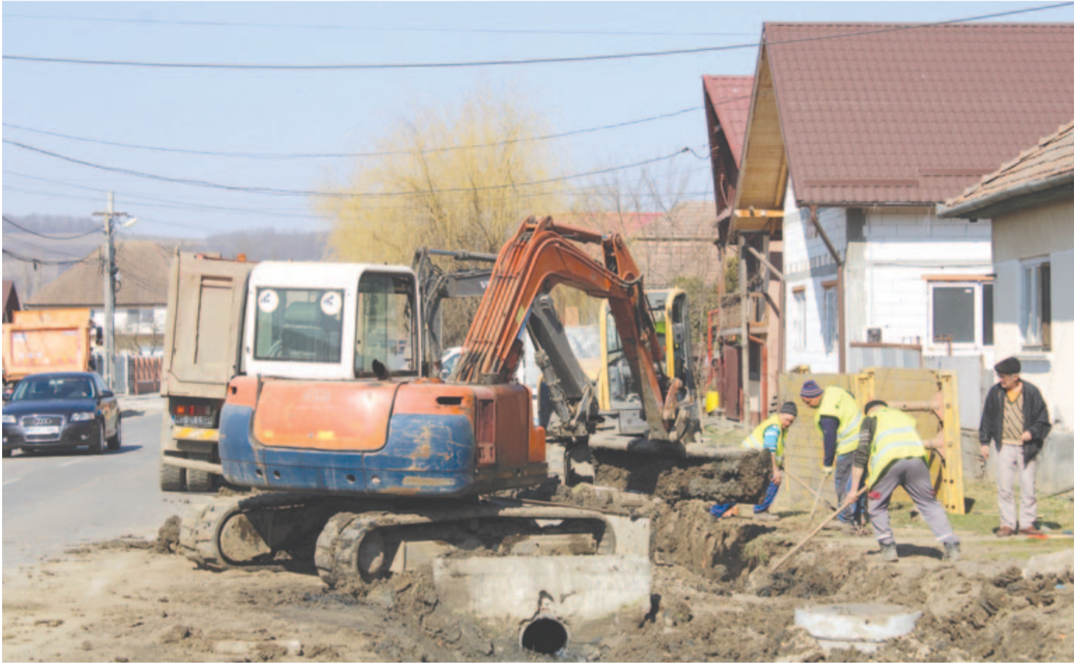
Kanalizálási munkálatok Mezőcsáváson
